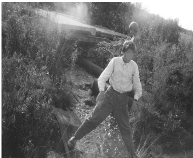
Состояние скважины в 1991г. Примерный дебит скважины не более 30 литров в секунду. На устье скважины остатки ремонтной площадки.
